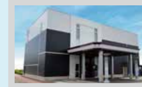
北名古屋ホール 北名古屋市長久手区熊之庄八幡111 平面駐車場 80台
